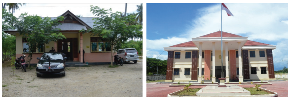
Gambar 5.9. Kondisi gedung Pengadilan Agama Marissa sebelum dan sesudah direnovasi
